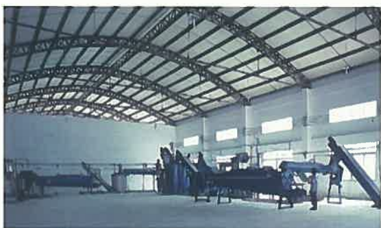
生産ブロック
