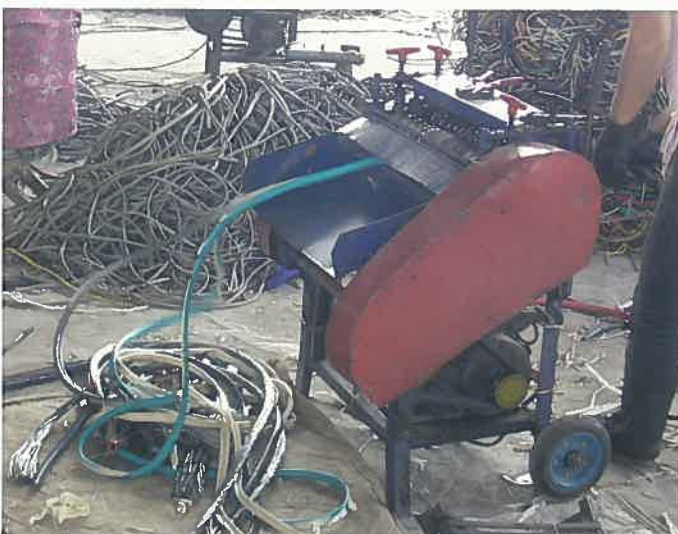
電線皮剥き作業
